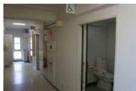
車いす対応トイレ
