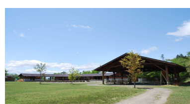
センター棟&屋根付き広場
