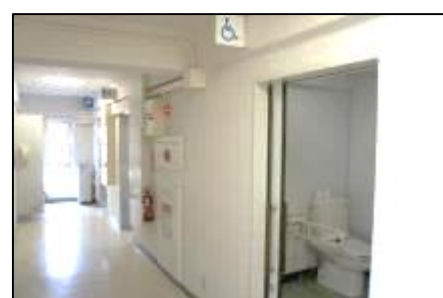
車いす対応トイレ
