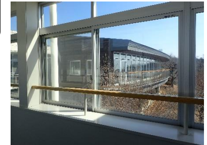
20点 ( A14 ) サービス棟南側エレベーター3階通路
